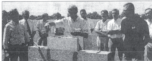
C'est jeudi à Aube que s'est déroulée la pose de la première pierre de la future résidence Opale
