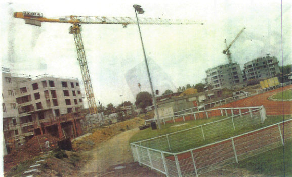
Autour du stade Prestavoine d'Hérouville, c'est le grand chantier de l'habitat depuis plus d'un an. Et tous les projets ne sont pas encore lancés...
